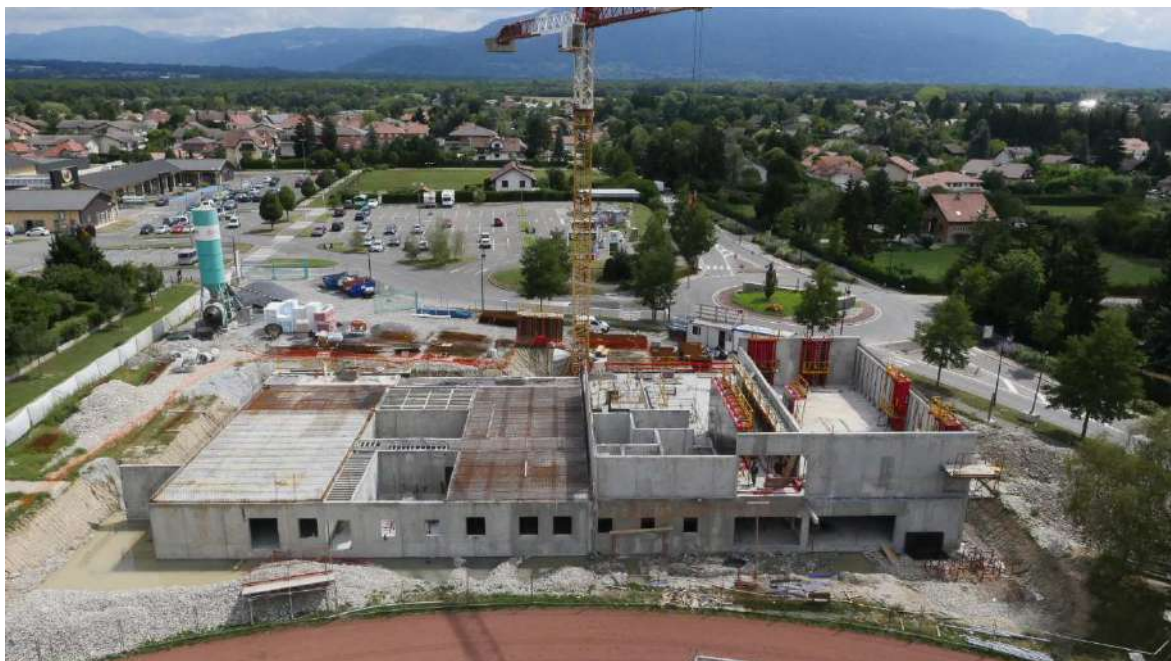
Réalisation des élévations du RdC bas et commencement élévations du RdC haut.
