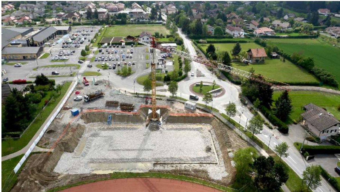
Après les terrassements généraux, l'empierrement de la plateforme.
