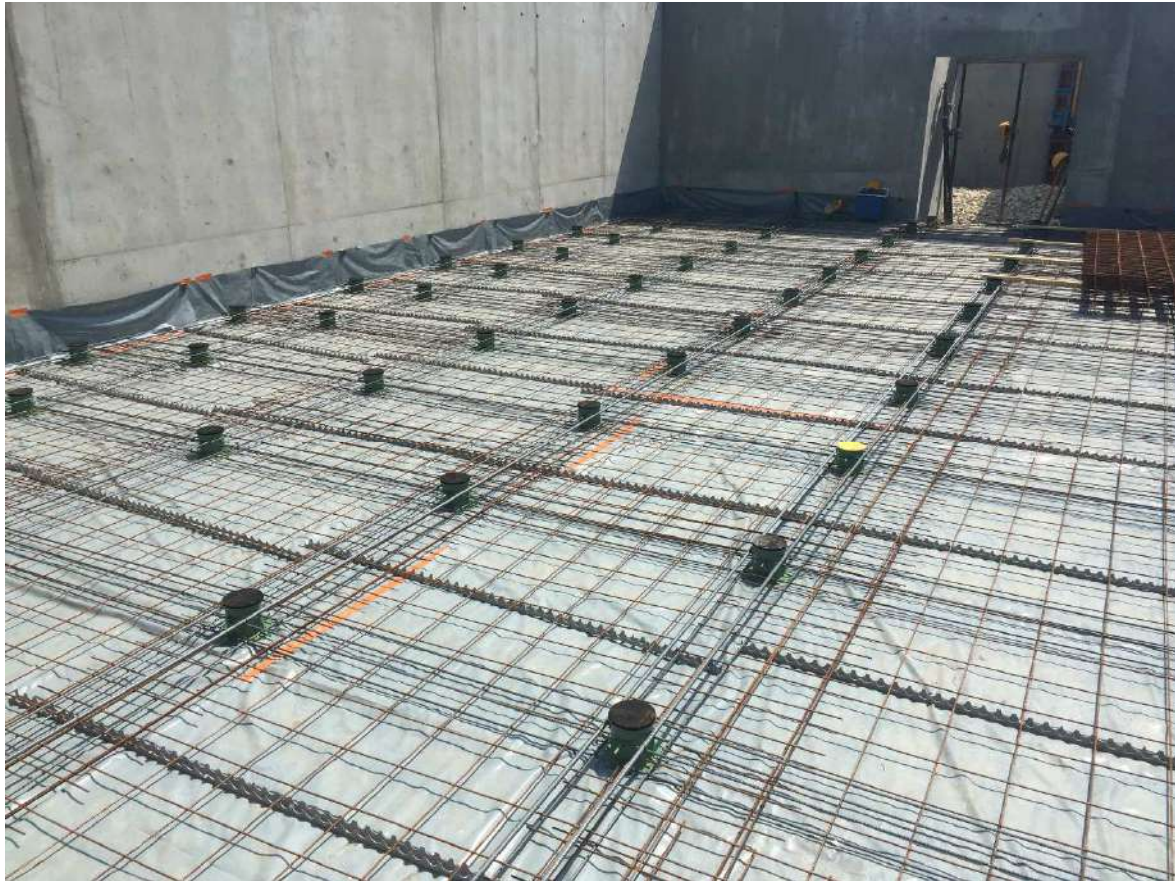
Pose des boîtes à ressort sur polyane de désolidarisation, puis ferrailage de la dalle
