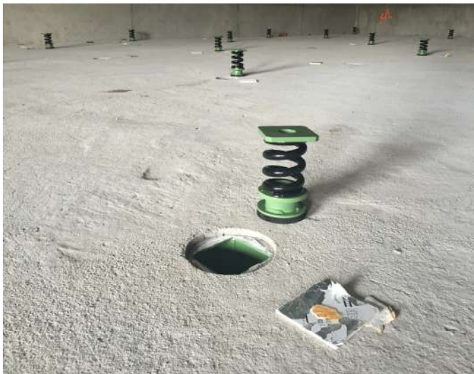
Mise en place des ressorts pour levage de la dalle.
