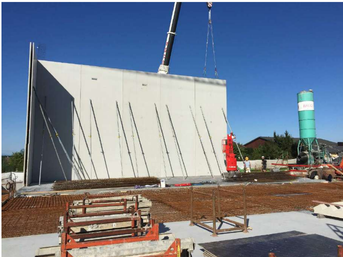
Pose des prémurs de grande hauteur.
