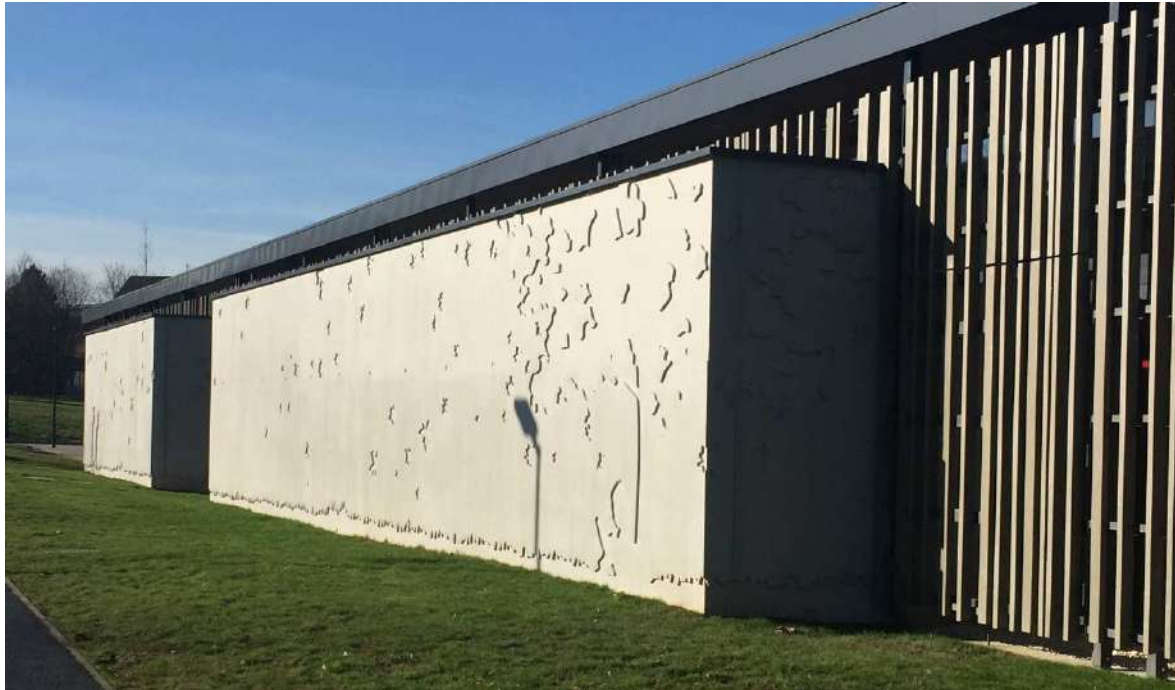
Les deux excroissances en béton matricé.
