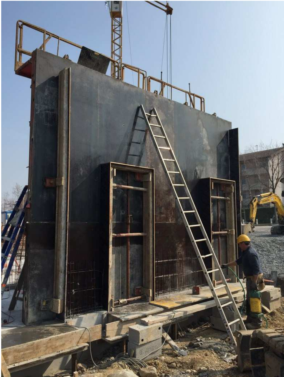
Coffrage d'un mur extérieur.
