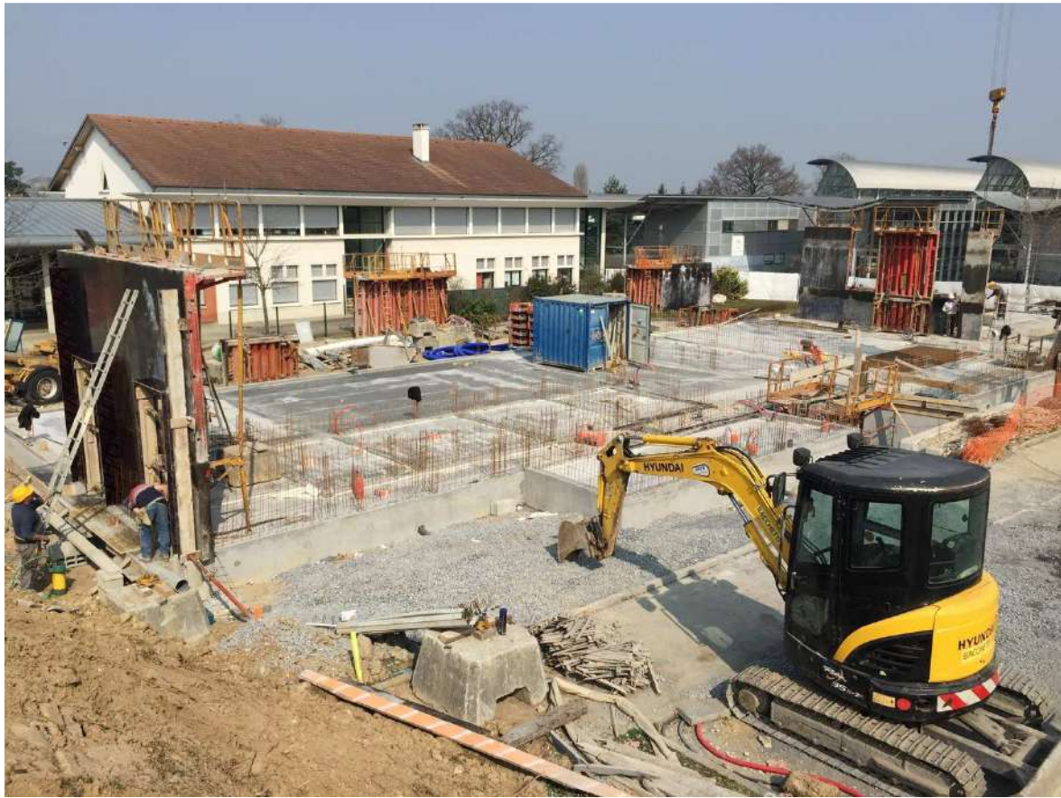
Remblais périphériques après réalisation du sous-sol technique.
