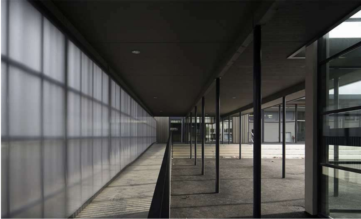
La coursive de liaison avec l'existant.
