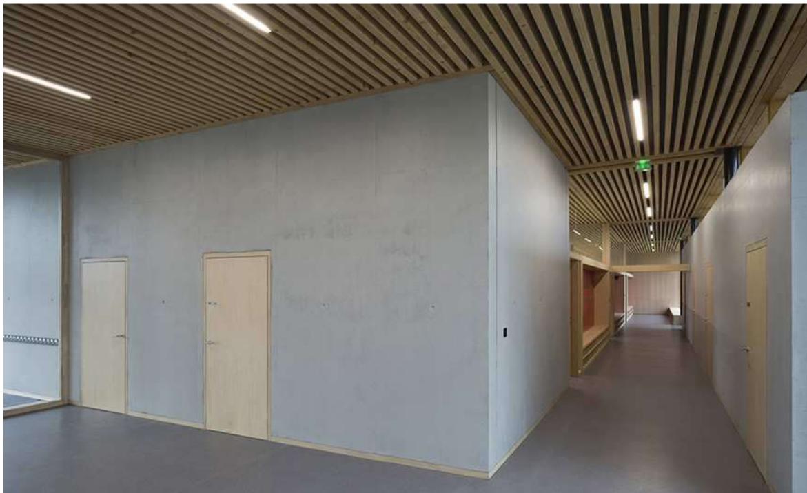
Murs en béton brut apparent, calepinage des trous de banches suivant détail Architecte.
